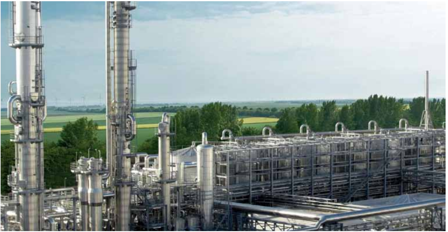
Bioethanolanlage der fuel 21 GmbH & Co. KG in Klein Wanzleben / Sachsen-Anhalt
